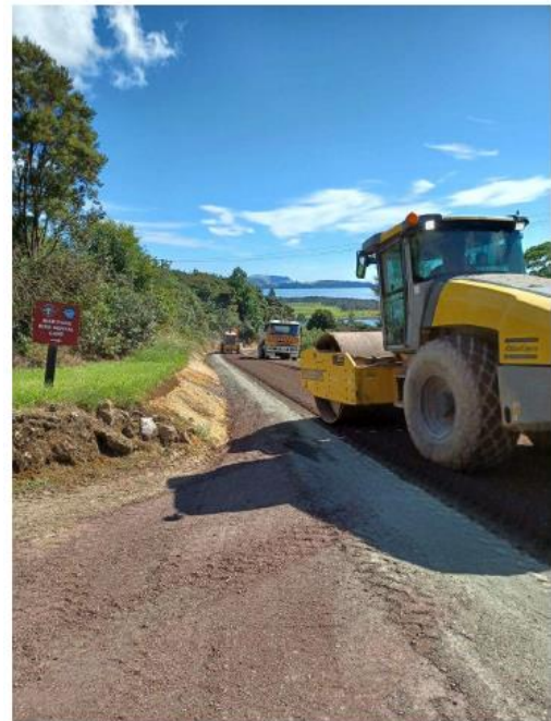
Bayly Rd – Stabilisation
