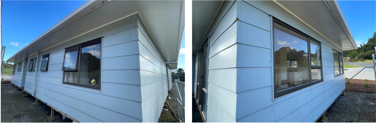
Actual building images
